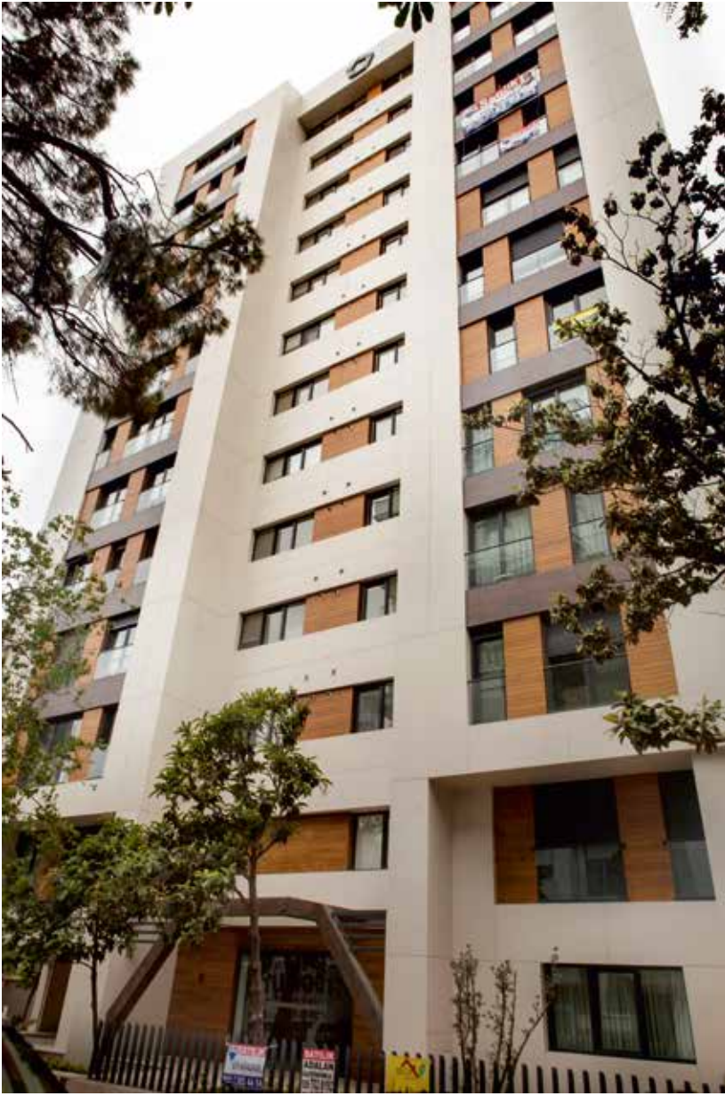
> Doras İnşaat Çağ Apt. / Caddebostan
